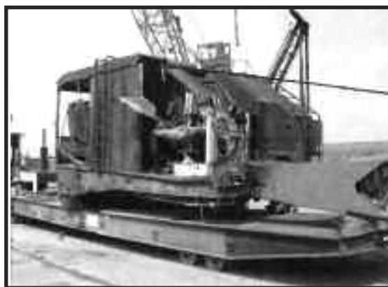
Wheco provádí opravu jeřábu American 9460. Před opravou.
