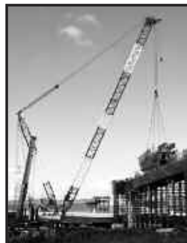
Uchimiya Transportation instalující pomocí Terex CC 6800 nosníky mostu.
