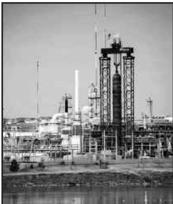
Bigge LTS s kapacitou 4000 tun, který může dosáhnout výšky až 120 metrů.
