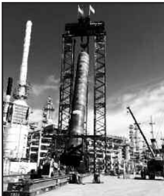
Bigge LTS s kapacitou 4000 tun, který může dosáhnout výšky až 120 metrů.
