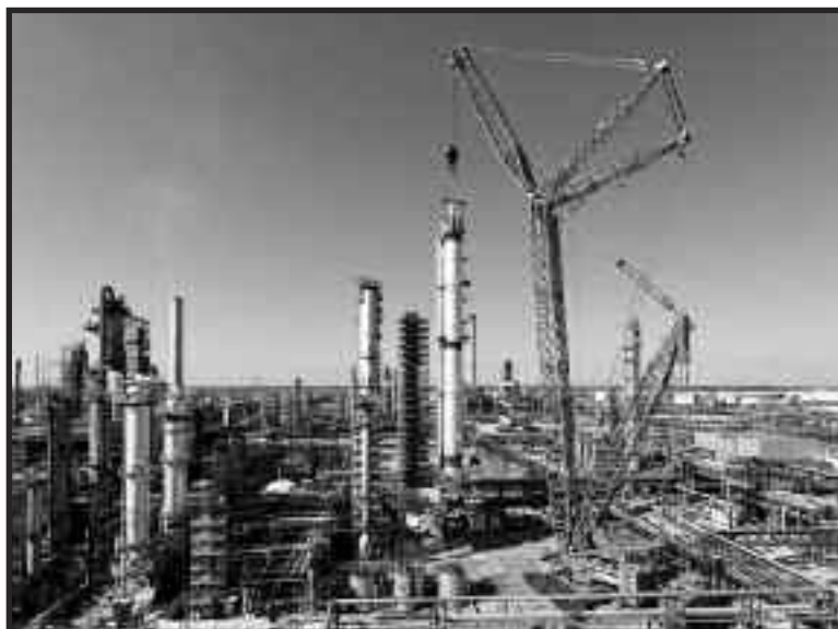
Felbermayr se svým Liebherr LR 11000 provádí rekonstrukci rafinérie v Rumunsku
