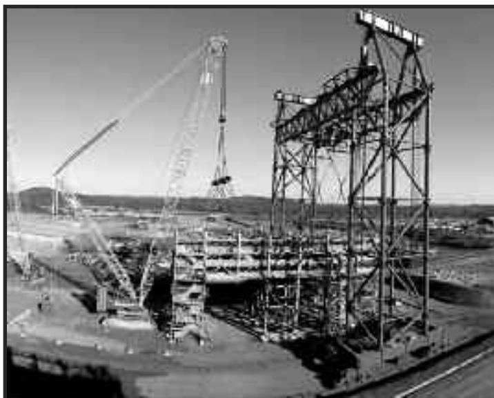
Společnost Sarens provádí stavbu petrochemického závodu.
