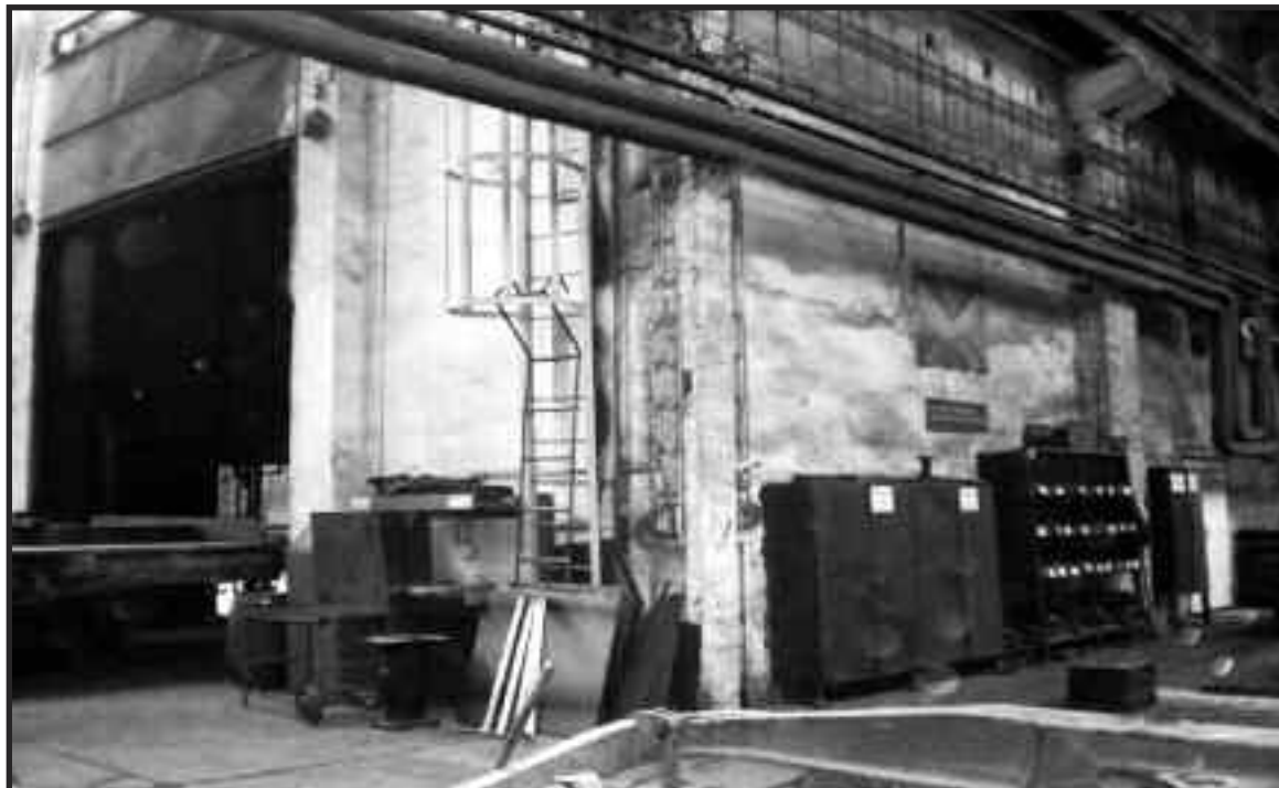
Obr. 4 Výstup do kabiny mostového jeřábu
