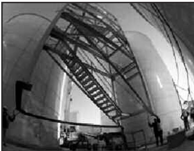
Ustavení schodišťové věže
